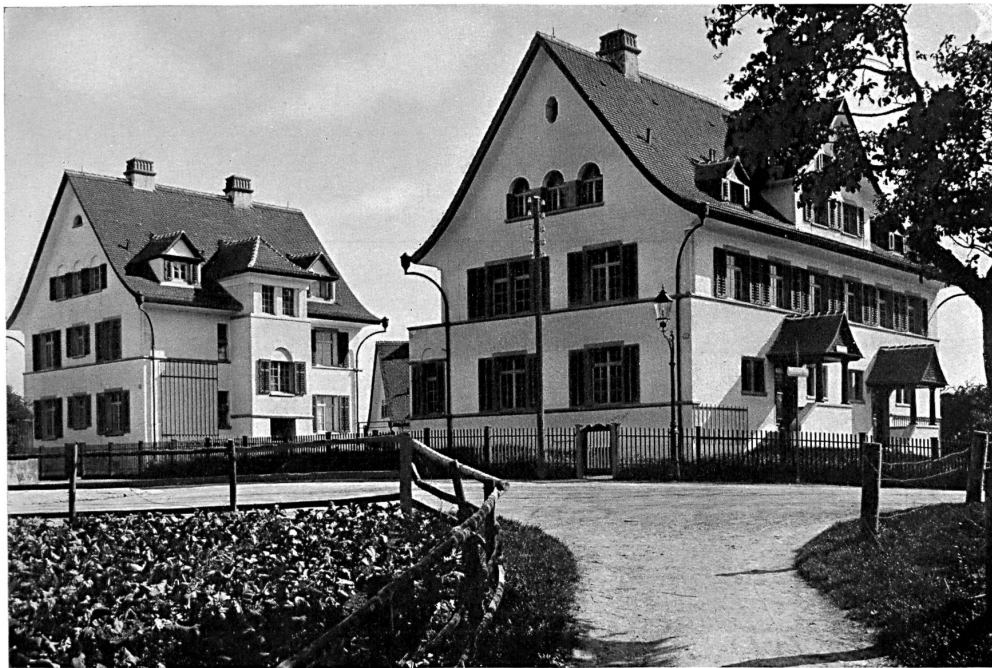
Maisons Sudstrasse 86 et 88 et Wonnebergstrasse 76.
