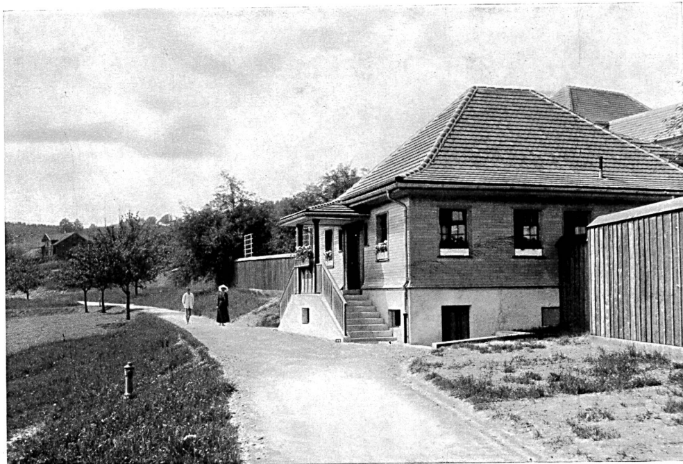
Bâtiment d'entrée de l'établissement de bains « Sennrüti » à Degersheim. Architecte Fritz Danzeisen, Degersheim; collaborateur architecte Paul Hasler, Degersheim.
