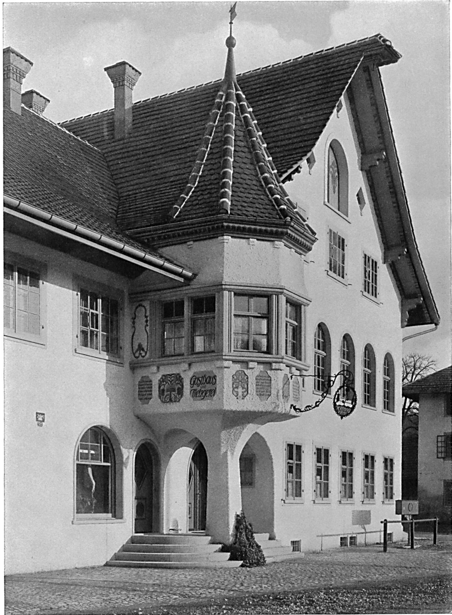
Maison d'habitation avec auberge. Architectes: Kündig & Oetiker, Zurich.
