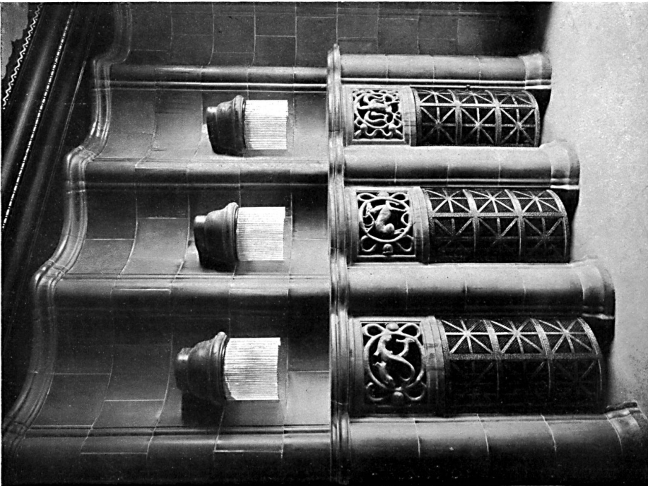
Détail de l'entrée du côté du Beatenplatz.
