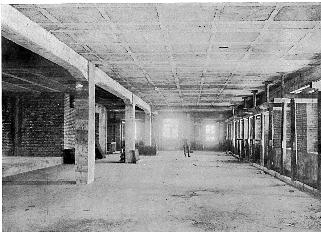
Vue d'en bas d'un plafond non lissé, de 8 m d'écartement.
