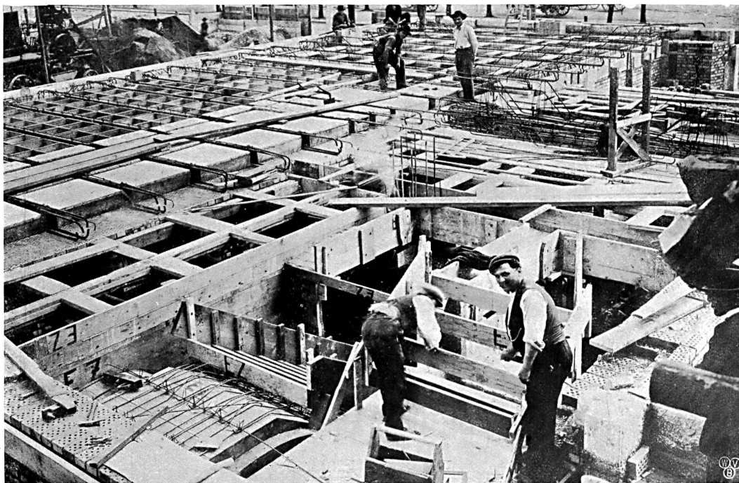
La couverture en béton; le remplissage des corps creux.
