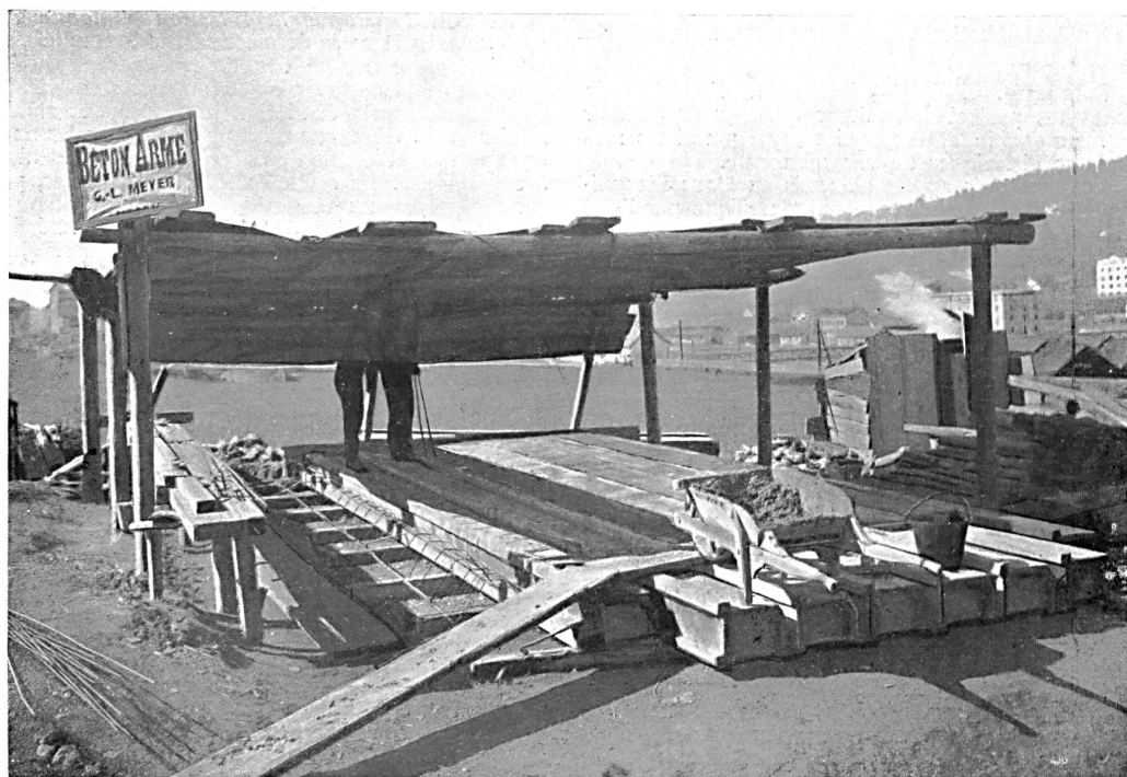
Le béton armé dans la construction d'immeubles industriels. Montage des poutres orthogones. Ing. G.-L. Meyer à Lausanne.
