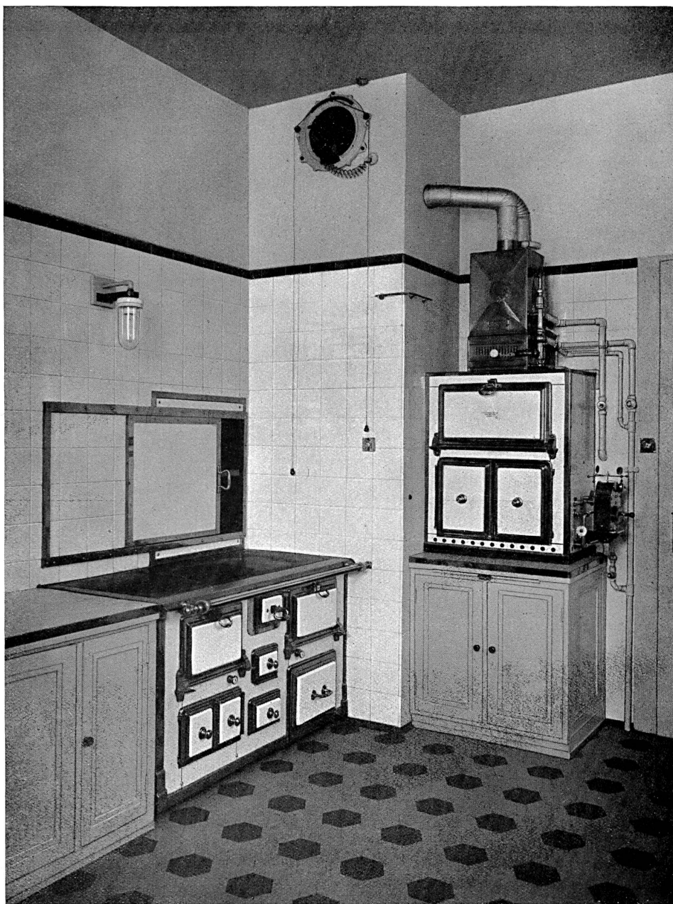
La cuisine dans la villa Wegelin-Hauser à St-Gall. Fourneau à charbon, chauffe-plats, réservoir d'eau chaude, gril, broche et four.
