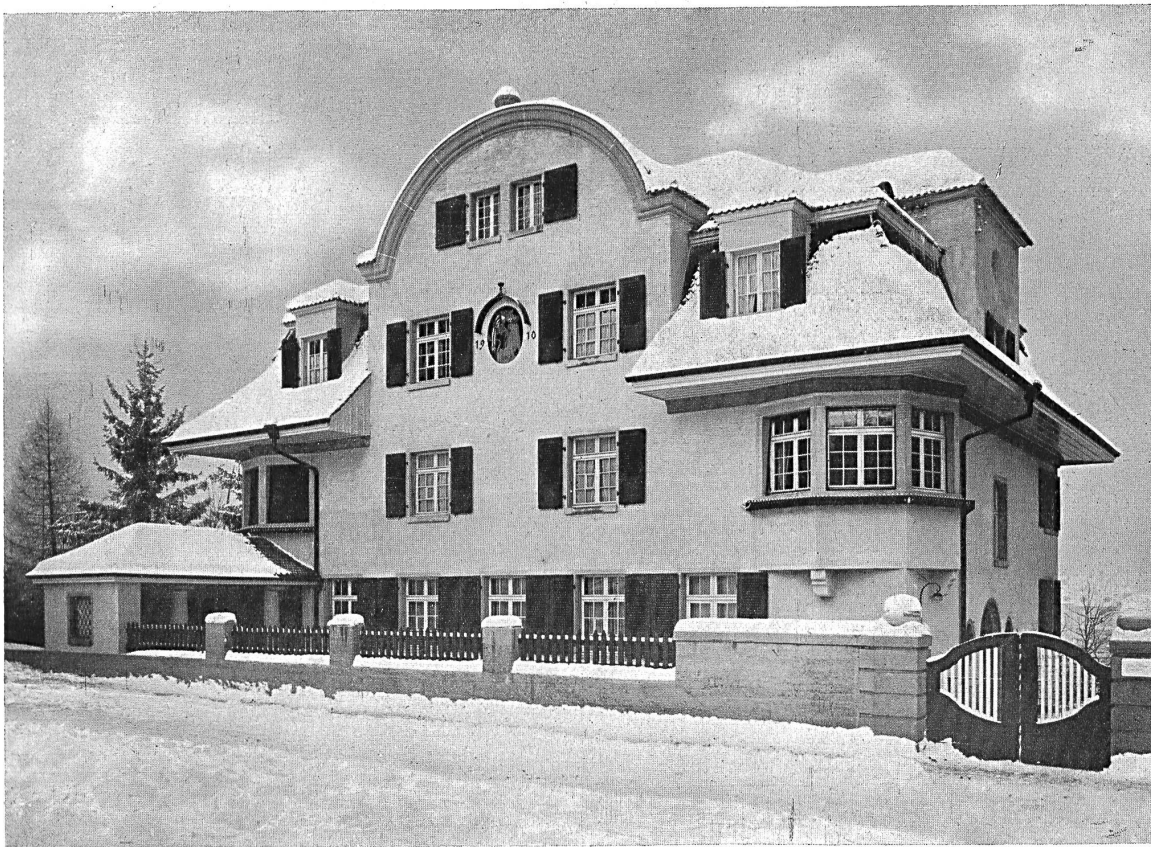
Maison Kollerweg 9, Berne :: Façade sud-est ::
