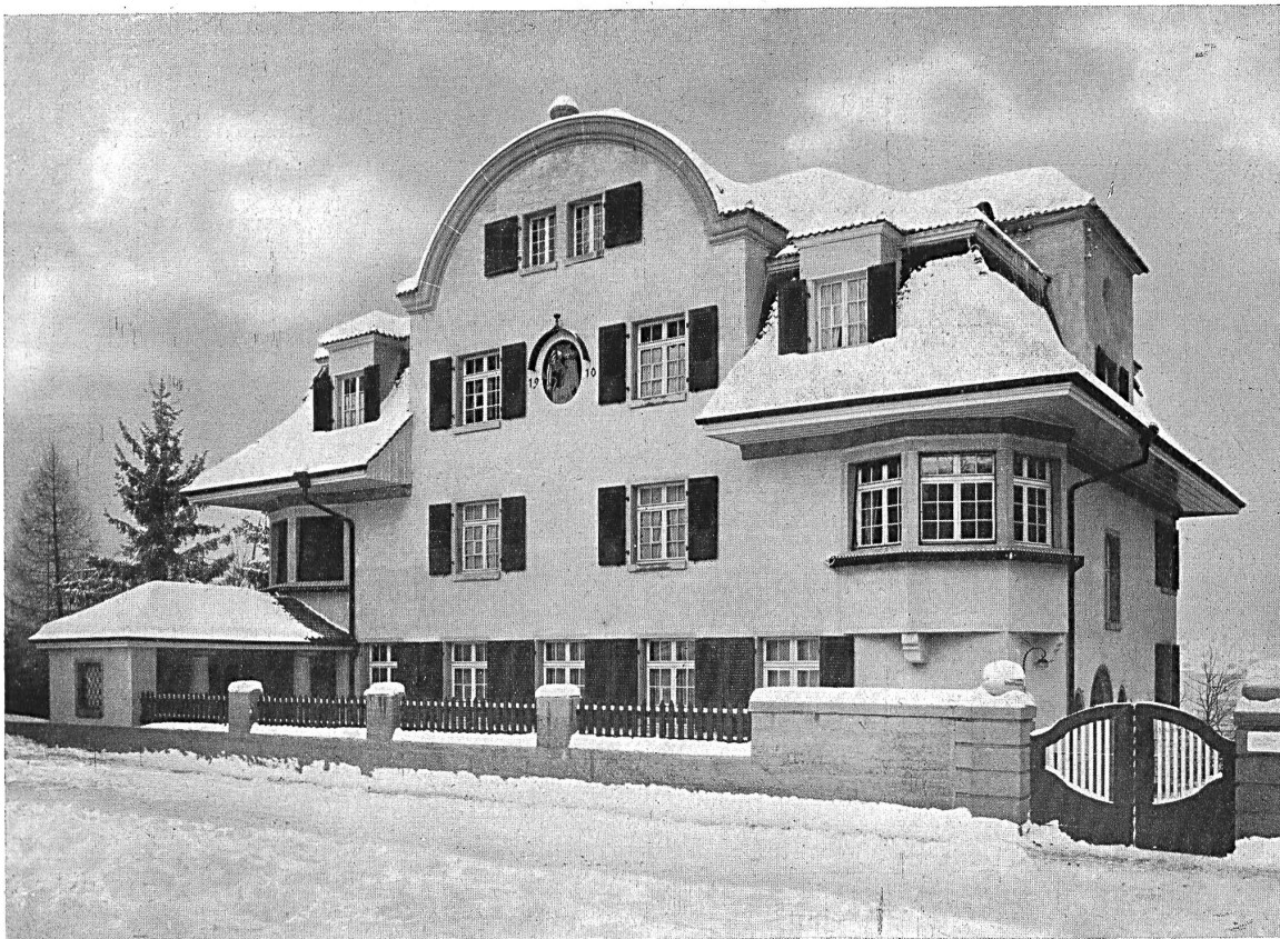
Maison Kollerweg 9, Berne :: Façade sud-est ::
