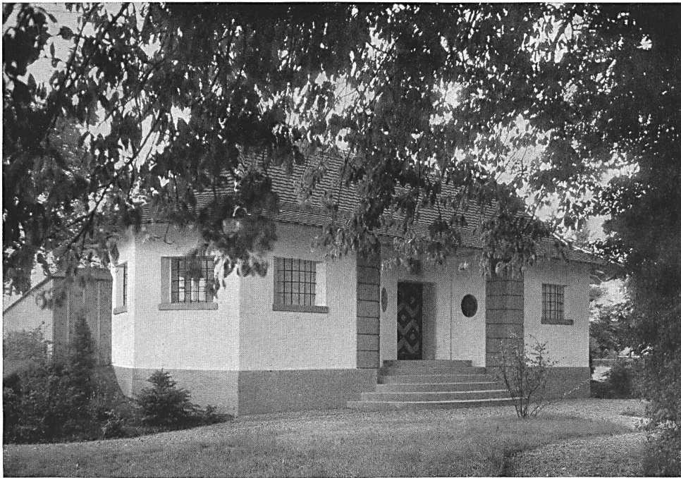
Façade du côté de l'entrée
