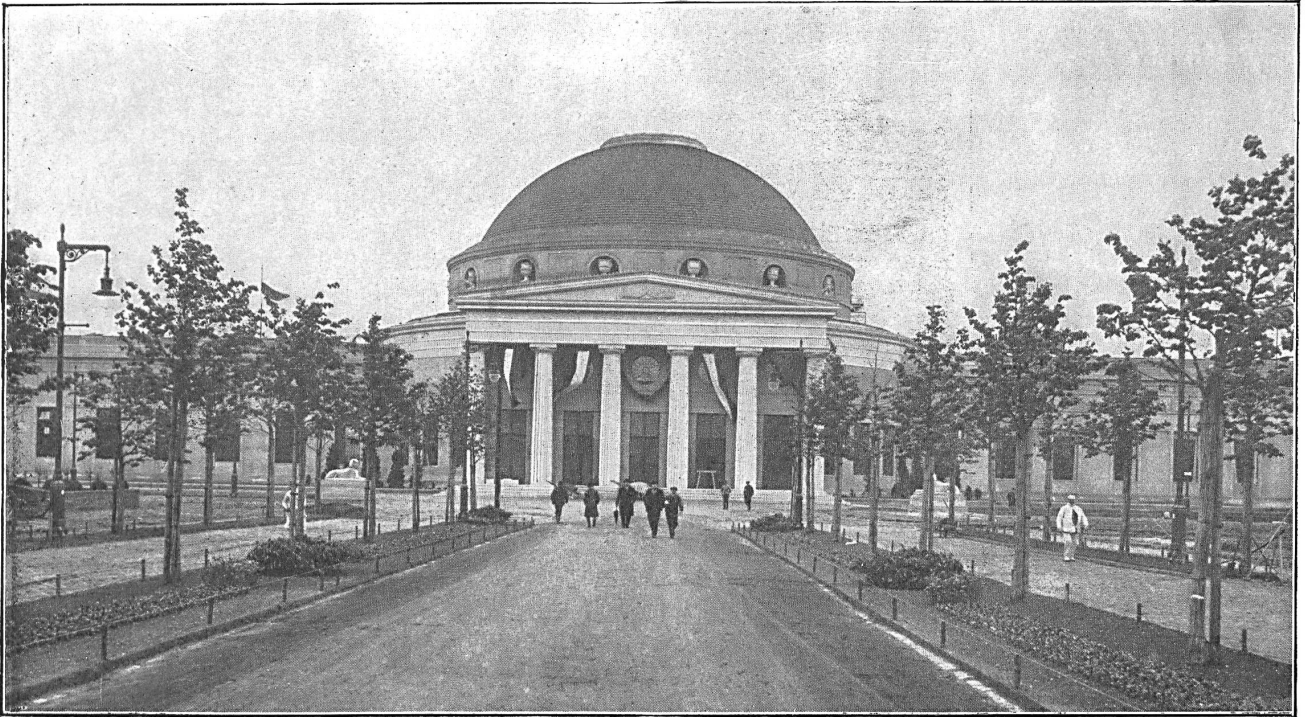
Exposition du bâtiment à Leipzig :: Hall en béton ::
