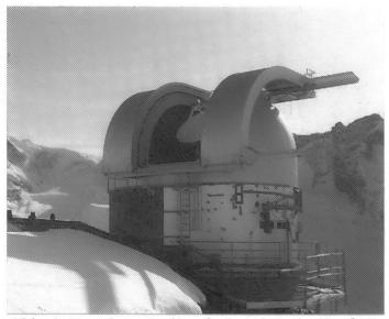
Abb. 4: Das 3 m Radioteleskop in seiner schützenden Kuppel.
