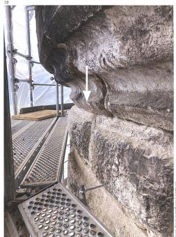
Abb. 17 und 18 Am oberen Rand der Rundtürme kam nach der Entfernung der Zementfuge (Abb. 18) eine Vertiefung zum Vorschein, die beim Aufbringen des Fugenmörtels einfach aufgefüllt worden war (Abb. 17).
