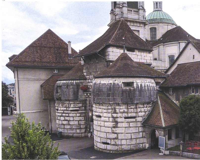
Abb. 10–12 Die starke Verschmutzung des Kalksteins war einer der Gründe für die Restaurierung des Baseltors von 2023.
