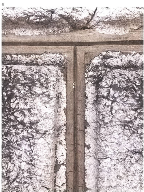
Abb. 8 Der Fugenstrich im oberen Bereich des Mittelturms endet an der Kante zur Seitenfassade. Dort blieben die Fugen offen. Zustand vor der Restaurierung.
