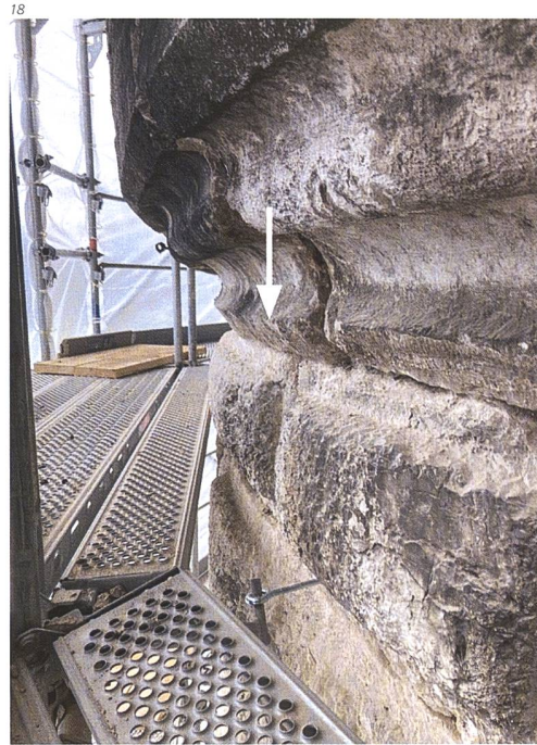
Abb. 17 und 18 Am oberen Rand der Rund- türme kam nach der Ent- fernung der Zementfuge (Abb. 18) eine Vertiefung zum Vorschein, die beim Auf- bringen des Fugenmörtels einfach aufgefüllt worden war (Abb. 17).
