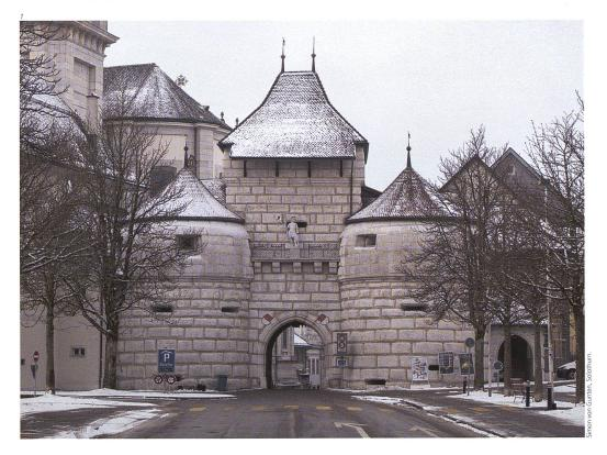
bereits aufgebraucht, der Bau aber noch nicht vollendet. Ein neuer Vertrag zur Fertigstellung sahgleichzeitig vor, alle drei Türme der Toranlage um zwei Klafter (ca. 5,7 Meter) höher zu bauen als ursprünglich geplant. Die Toranlage besass noch keine Ziegeldächer, offene Plattformen mit Zinnen bildeten die oberen Turmabschlüsse.
