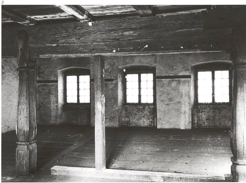
Abb. 3 Olten, Kirchgasse 15, barocke Konstruktion aus Stützen und Balken vor dem Umbau 1969. Die massive Konstruktion wurde vermutlich 1746 beim Umbau zur Kornschütte ein- gebaut. Archiv der kantonalen Denkmalpflege Solothurn, Foto vor 1969.
