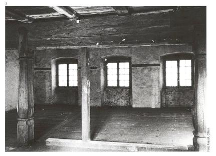
Abb. 3 Olten, Kirchgasse 15, barocke Konstruktion aus Stützen und Balken vor dem Umbau 1969. Die massive Konstruktion wurde vermutlich 1746 beim Umbau zur Kornschütte eingebaut. Archiv der kantonalen
