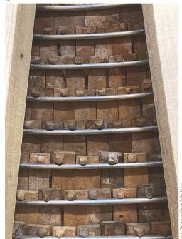
Abb. 13 Neue Ziegellattung aus Stahlrohren im Bereich des Chorrunds.
