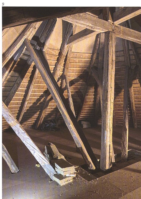
Abb. 10 Ansicht der Dachstuhlkonstruktion nach der Ertüchtigung.
