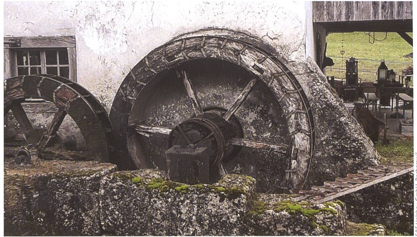
Abb. 15 Ersatzschaufeln aus Blech und abgewitterte Segmente.
