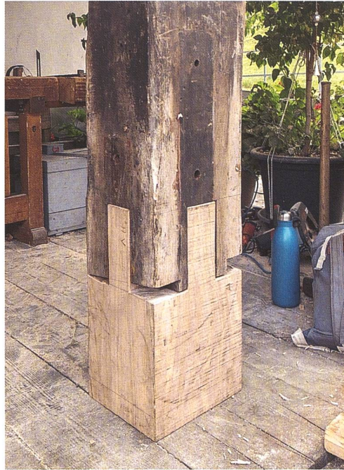
Abb. 22 Der Hammerbock mit den er- setzten, unteren Querhölzern.
