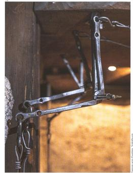
Abb. 12 Umlenkung im oberen Turmhelm für den Stundenschlag auf der grossen Glocke.
