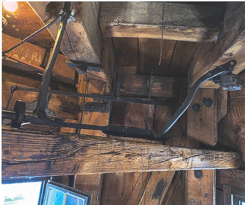
Abb. 12 Umlenkung im oberen Turm- helm für den Stundenschlag auf der grossen Glocke.
