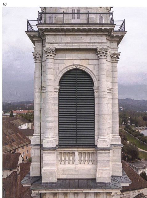
Abb. 10 Solothurn, Turm der St.-Ursen-Kathedrale. Ansicht der Glockenstube nach der Erneuerung der Jalousien.
