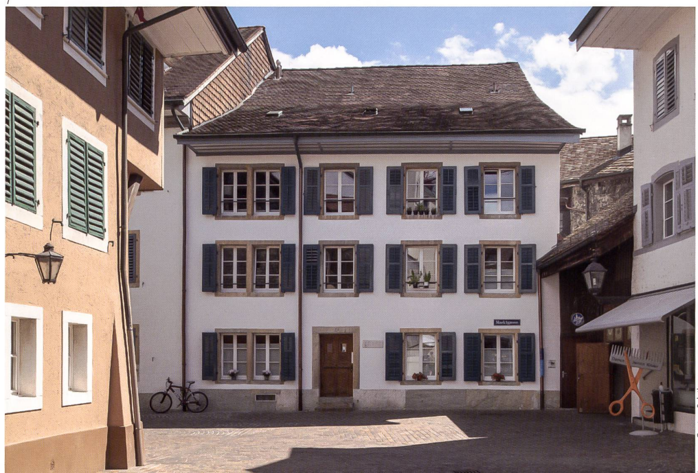
Abb. 1 Olten, Marktgasse 27. Gassen- ansicht des Alten Spittels. Rechts im Hintergrund ist die Rundung des Hexenturms zu erkennen. Zustand nach der Restaurierung 2022.
