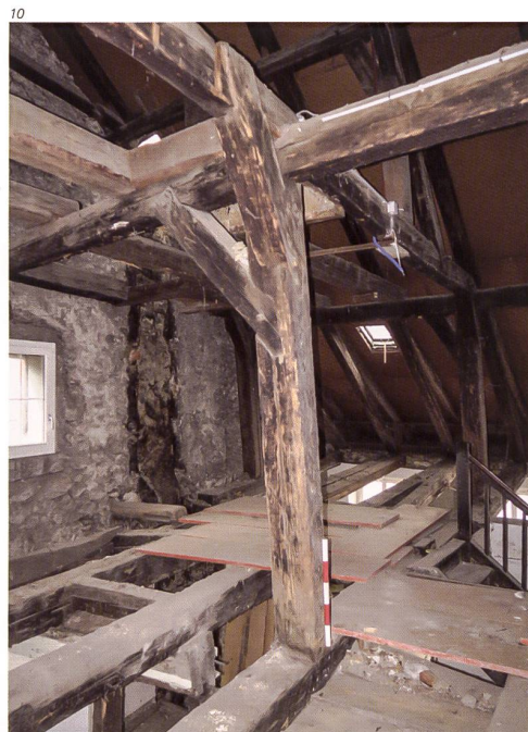
Abb. 8 Olten, Marktgasse 27. Stube im ersten Obergeschoss, Westwand mit Rillenfriesbalken und jüngeren Unterzügen. Situation beim Umbau 2020.
