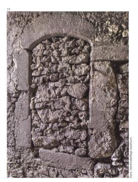
Abb. 11 Olten, Marktgasse 27. Vermauerter Hocheingang zum Obergeschoss des Hexenturms. Zustand 2020.
