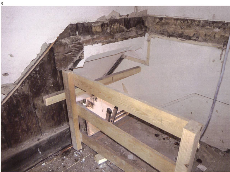
Abb. 8 Olten, Marktgasse 27. Stube im ersten Obergeschoss, Westwand mit Rillenfriesbalken und jüngeren Unterzügen. Situation beim Umbau 2020.
