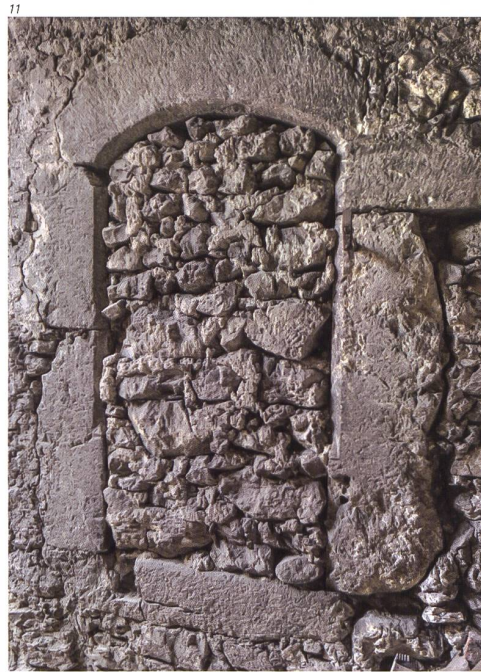
Abb. 11 Olten, Marktasse 27. Vermauerter Hocheingang zum Obergeschoss des Hexenturms. Zustand 2020.
