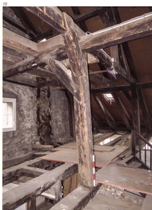
Abb. 8 Olten, Marktgasse 27. Stube im ersten Obergeschoss, Westwand mit Rillenfriesbalken und jüngeren Unterzügen. Situation beim Umbau 2020.
