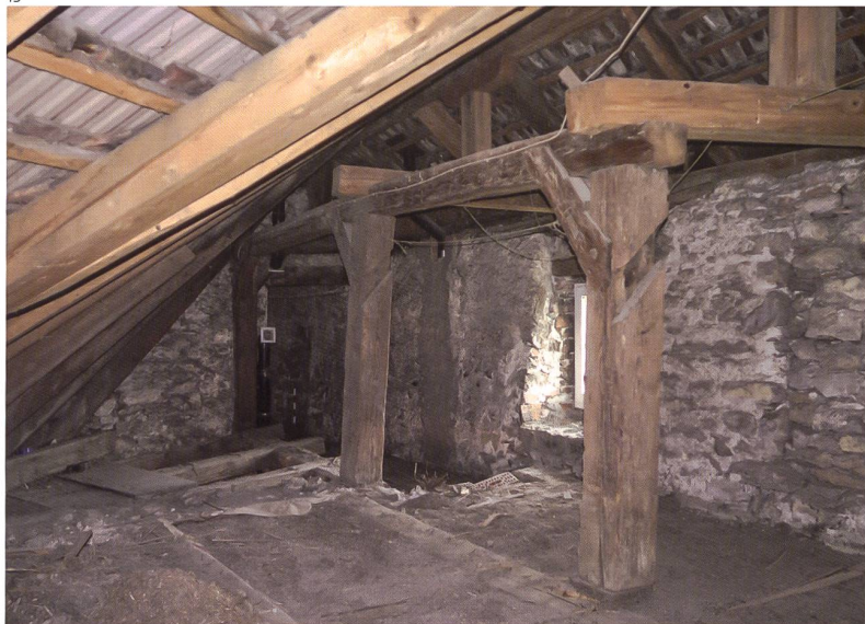
Abb. 13 Olten, Marktasse 27. Gedeck- te Wehrgangkonstruktion von 1690 über dem Hexenturm. Links im Hintergrund ist die westliche Giebelwand des Spittels zu erkennen. Zustand vor dem Umbau 2020.
