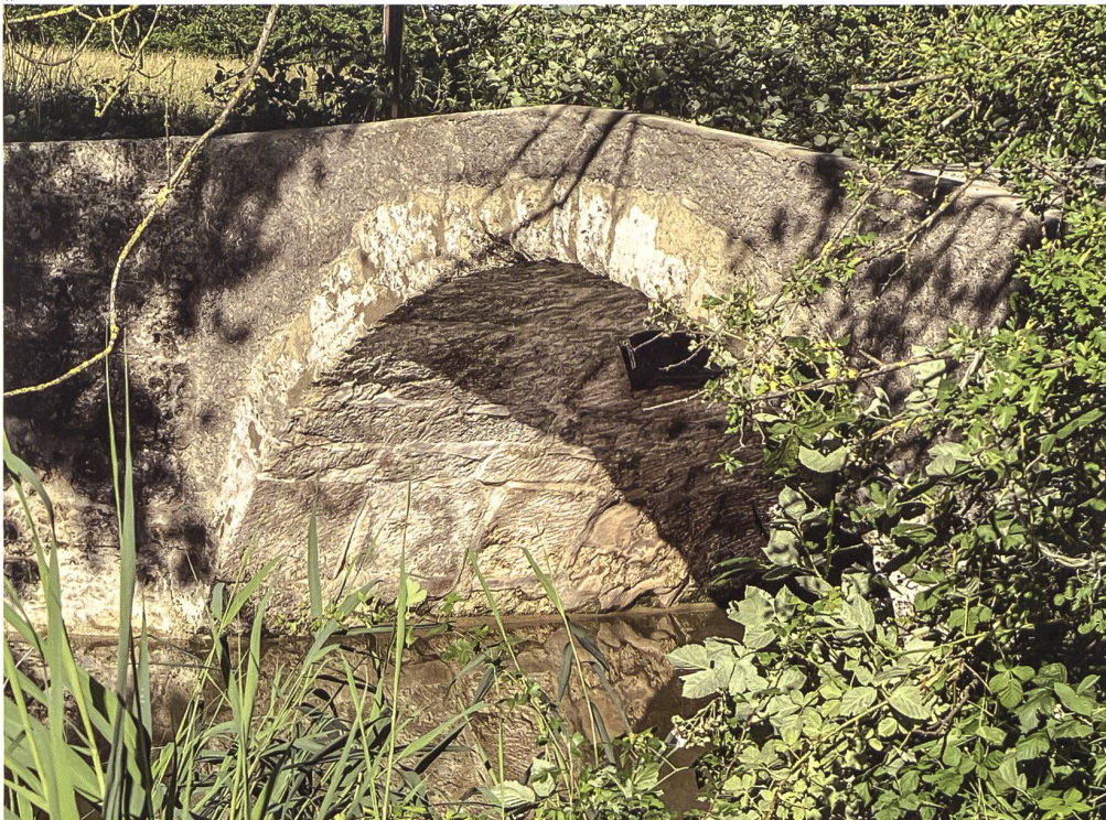
Abb. 17 Untersicht und Seitenansicht des Gewölbes mit neu ausgefugtem Mauerwerk sowie neu verputzter Seitenmauer. Foto 2021.
