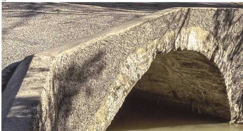
Abb. 15 Die restaurierte «Römerbrücke» mit instandgesetztem Steingewölbe, neu verputzter Seitenmauer und mit Splittkies eingestreuter, neuer UHFB-Fahrbahnplatte.
