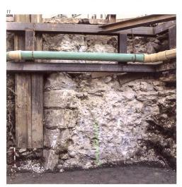
höhte dadurch die Stabilität der Mauer. Im rückwärtigen, aufgeschütteten Teil der Schanze war die Mauer M8 mit 1×0,8 Meter grossen Stützpfeilern verstärkt.
