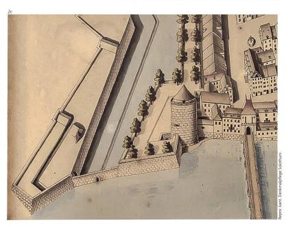
Katzenstegturm ersetzt (Abb. 2b). Der kreisrunde Turm sprang weit von der Stadtmauer hervor. Der Stadtgraben mitsamt Gegenmauer führte nun weiter westlich bogenförmig um das neue Bauwerk herum. Nördlich des Turms errichtete man den hölzernen «Katzensteg», der über den Wehrgraben zu einem Schlupftor in der Stadtmauer führte.
