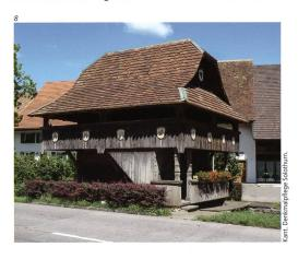
gel wurden nach dem Abdecken kontrolliert, gebürstet und wieder verlegt. Die für Speicherbauten typische Einfachdeckung wurde beibehalten, die Fugen mit handgespaltenen Holzschindeln unterlegt. Nordseitig mussten zusätzlich einzelne morsche Sparren ersetzt werden.
