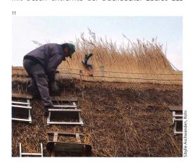
Moos. Anschliessend füllte er die Löcher mit sogenanntem Reparaturschilf, das kürzer ist als das eigentliche Deckschilf. Zum Schluss richtete er die gesamte Dachfläche mit dem sogenannten Schlagbrett wieder aus. Nun ist «der Rock wieder geglättet» und «das Kleid wieder trapiert», sodass sich das Hochstudhaus wieder stolz und herausgeputzt präsentiert und der Strohdachdecker weiterziehen kann.
