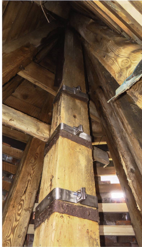
Abb. 12 Stabilisierungsmassnahme an der Dachstuhlkonstruktion.
