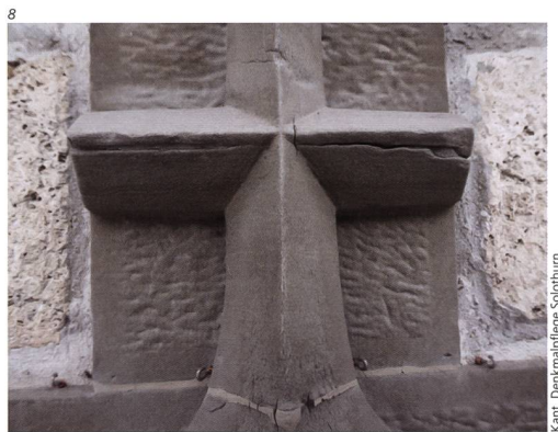
Abb. 9 Offene Fugen beim Kalkstein.
