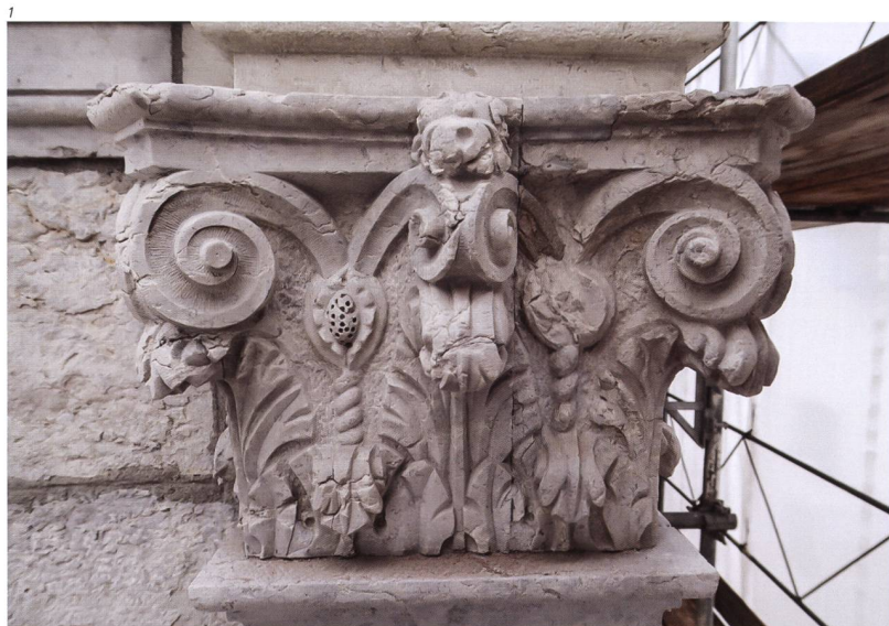
Abb. 1–2 Details der Fassadendekoration aus Solothurner Kalkstein am südlichen Seitenturm. Links ein korinthisches Kapitell eines Eckpilasters im zweiten Obergeschoss, rechts ein ionisches Kapitell im ersten Obergeschoss.
