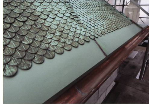
Abb. 12 Instand gestellter Dachanschluss an den Tuffsteinturm.
