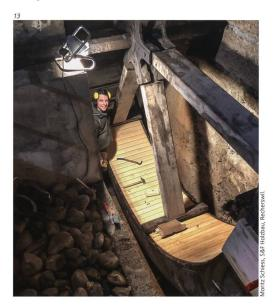
Abb. 14 Der neugefertigte Sturzkanal mit Eisenbändern.
