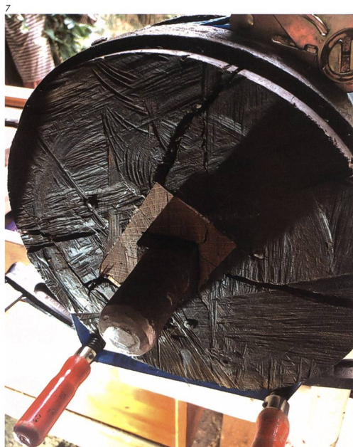
Abb. 10 Die neuen Stege des Korbrades am Wellbaum.
