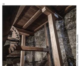
bestehenden Unterzug liegt, ist der Pfosten mit einem 30 mm hohen, aus dem Balken herausgearbeiteten Holzzapfen fixiert. Im betonierten Sockel wird er durch einen Eisenstab gehalten, der beim Aufstellen des neuen Pfostens in ein Loch im Balken geschoben wurde. Beim Schieben an die richtige Position auf dem Sockel fällt der Stab in ein vorher gebohrtes Loch und fixiert den Pfosten so gegen das seitliche Verschieben (Abb. 19).
