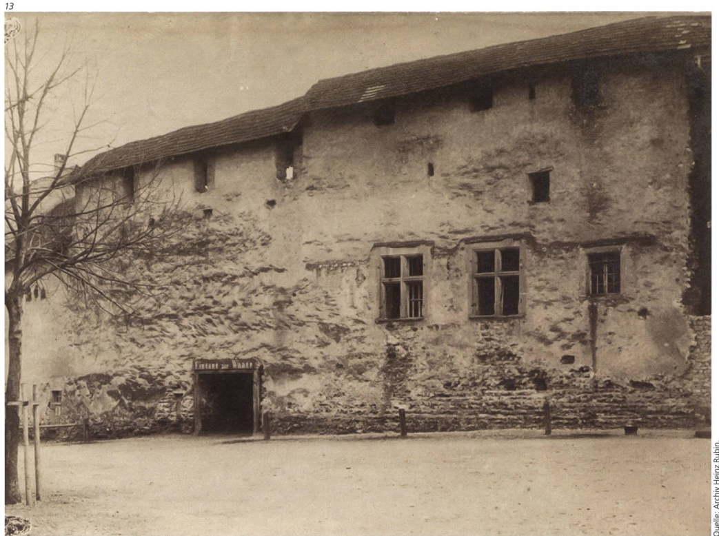
Abb. 14 Olten/Klosterplatz 15. Die Castrumsmauer wurde beim Neubau des Gebäudes 1968 bis auf ein 5,8 Meter langes Teilstück abgebrochen.
