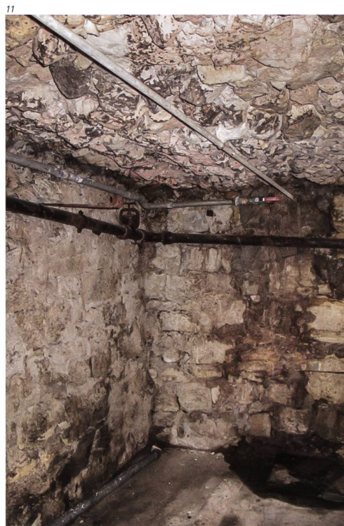
Abb. 10 Olten/Klosterplatz 23 (Nr. 13). Die Castrumsmauer ist in diesem Keller noch erhalten. Ihre Breite von rund 3 Metern lässt sich dank der Fensteröffnung messen bzw. abschätzen.
