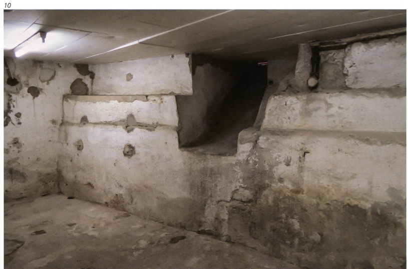
Abb. 10 Olten/Klosterplatz 23 (Nr. 13). Die Castrumsmauer ist in diesem Keller noch erhalten. Ihre Breite von rund 3 Metern lässt sich dank der Fensteröffnung messen bzw. abschätzen.
