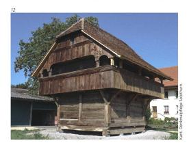
Dach wurde abgebaut. Mit viel Eigenleistung und Herzblut wurde der Speicher auf neue Fundamente gestellt und restauriert. Das Dach erhielt wieder die alten Biberschwanzziegel.
