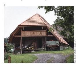
rotem Rahmen auf dem Türsturz im Erdgeschoss angebracht. Die Dachhaut sowie die Freibünde, mit Abhänglingen und Knäufen in der Hauptfront, waren in einem schlechten Zustand und mussten erneuert werden, während der durch das grosse Vordach geschützte Kernbau keine grossen Schäden aufwies.
