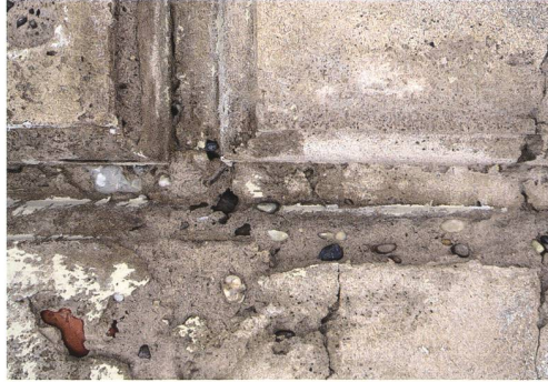
Abb. 12–15 Nordfassade, Zustand des originalen Verputzmörtels nach der Entfernung des Dispersionsanstrichs. Die Oberflächen sind zum Teil stark beeinträchtigt, hervorgerufen unter anderem durch den zu dichten Fassadenanstrich. Zahlreiche ältere Zementflücke sind sichtbar.
