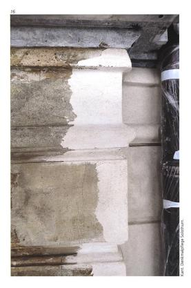
te Fassade. Aus welcher Zeit diese Anstriche stammen, ist nicht bekannt. Bei der Instandstellung der Fassade wurde gleich wie an der Südfassade vorgegangen. Mit Glasperlen als Strahlgut entfernte man den schadhaften und Schaden verursachenden Dispersionsanstrich bis auf die Oberfläche des originalen Verputzmörtels. Die Idee, die Fassade eventuell wieder in ihrer ursprünglichen Verputzsichtigkeit zu zeigen, konnte leider nicht weitergeführt werden.
