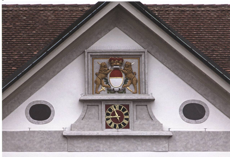
Abb. 8 Der Mittelgiebel der Innenhof-fassade im Zustand nach der Restaurierung von 2017. Die originale Farbigkeit konnte aufgrund von Befunden wiederhergestellt werden.
