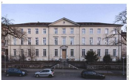
(Abb. 7) ist zudem ersichtlich, dass zu dieser Zeit sämtliche Fenster mit Läden oder Vorfenstern ausgestattet waren, welche aber in den 1970er Jahren entfernt wurden. Dafür erhielten einige Fenster aussenseitige Lamellenstoren in diversen Ausführungen, was der strengen Symmetrie und dem einheitlichen Erscheinungsbild der Fassaden abträglich war.
