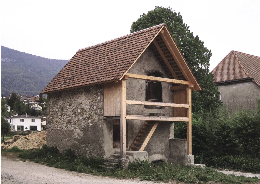
Abb. 1 Selzach, Speicher Bellacherstrasse 1b, nach der Restaurierung 2019. Die Laube wurde rekonstruiert und das Dach wiederhergestellt. Das Fassadenmauerwerk mit seinen älteren Verputzflicken konnte grösstenteils belassen werden. Der eingestürzte ostseitige Anbau wurde ersatzlos abgerissen.
