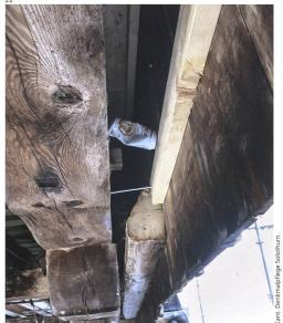
dem die äusseren, an der Oberwasserseite liegenden Pfosten der Pfeiler, die als zusätzlicher Prallschutz gegen Schwemmgut dienen, leicht erhöht.
