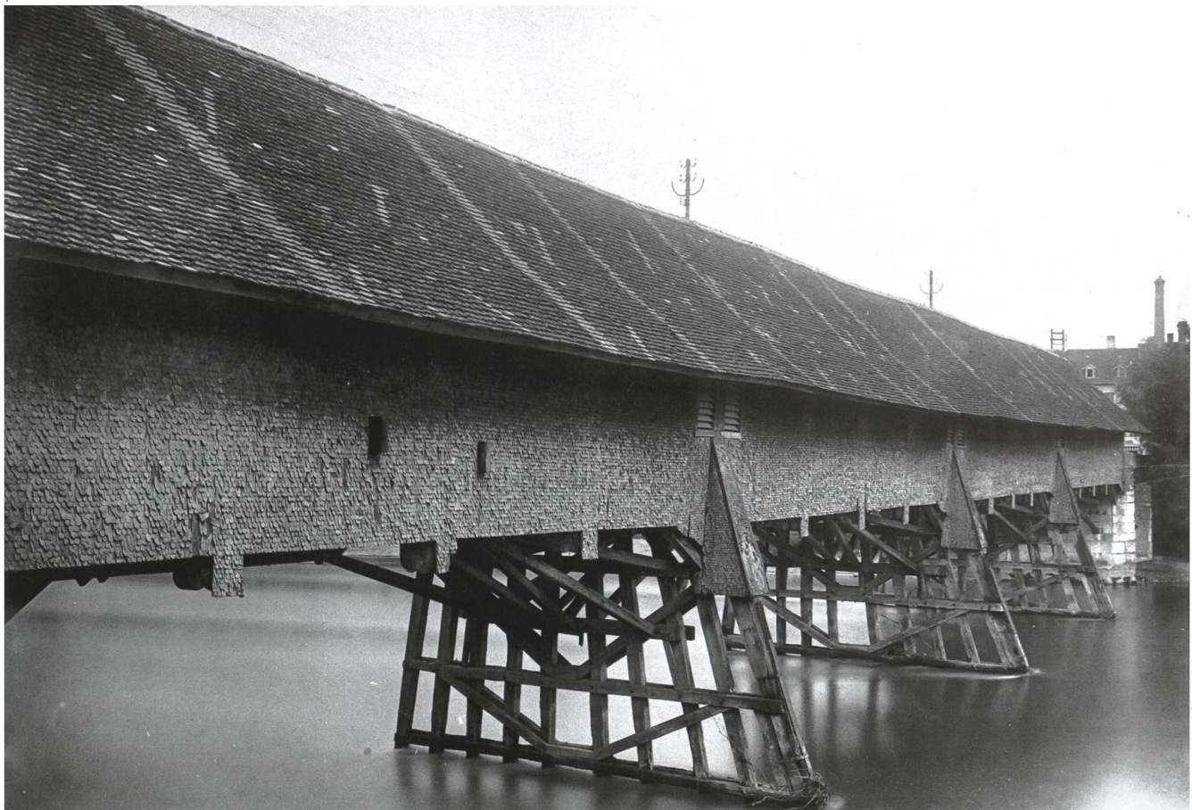
Abb. 1 Südwestansicht der Brücke mit Schindelschirm, der in der zweiten Hälfte des 20. Jahrhunderts durch eine Brettschalung ersetzt wurde. Foto um 1902.
