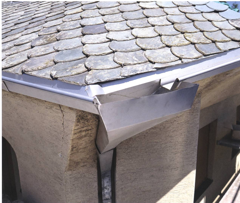
Abb. 12 Detailansicht des Dachs mit neuer Eindeckung aus norwegischem Naturschiefer.
