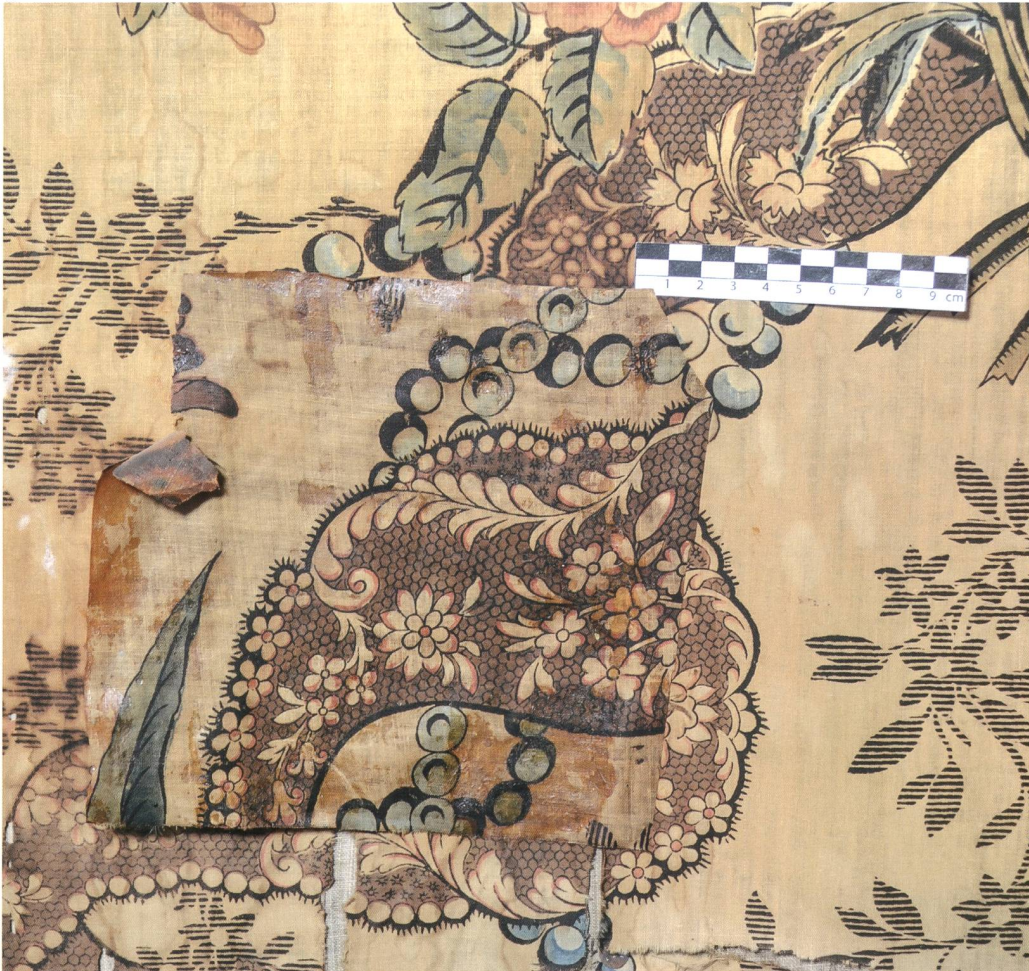
Abb. 13 Detail der Wandbespannung im Alkoven, ein ausgeschnittenes Stück Wandbespannung wurde als Reparatur über eine grosse Fehlstelle geklebt.
