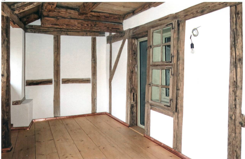
Abb. 17 Der hintere Teil des ersten Obergeschosses nach der Restaurierung. Er wurde neu als offener Bereich mit Treppe, Küche und Essplatz konzipiert. Ein Teil der Balkendecke von 1549/50 konnte restauriert und sichtbar gemacht werden.
