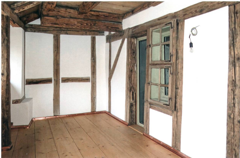
Abb. 17 Der hintere Teil des ersten Obergeschosses nach der Restaurierung. Er wurde neu als offener Bereich mit Treppenhaus, Küche und Essplatz konzipiert. Ein Teil der Balkendecke von 1549/50 konnte restauriert und sichtbar gemacht werden.
