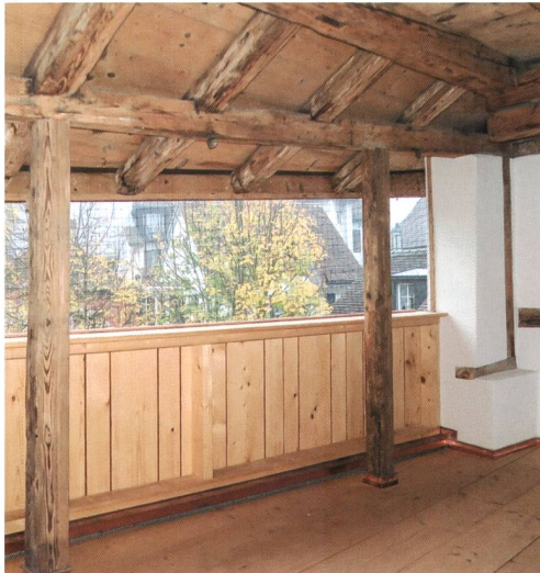
Abb. 17 Der hintere Teil des ersten Obergeschosses nach der Restaurierung. Er wurde neu als offener Bereich mit Treppenhaus, Küche und Essplatz konzipiert. Ein Teil der Balkendecke von 1549/50 konnte restauriert und sichtbar gemacht werden.
