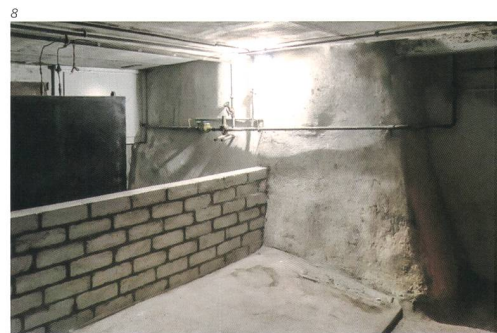
Abb. 9 Mittelbereich des ersten Obergeschosses, Blick gegen Süden. Im vorderen Bereich des Bodens sind die Balken von 1549/50 sichtbar. Der letzte stiess an die römische Castrumsmauer. Die Deckenbalken im vorderen Bereich gehören bereits zur nördlichen Erweiterung von 1643/44 und rechnen mit dem Abbruch der Mauer.
