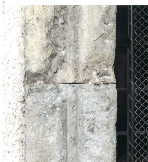
Abb. 9 Detail eines stark beschädigten Fenstergewändes vor der Restaurierung.
