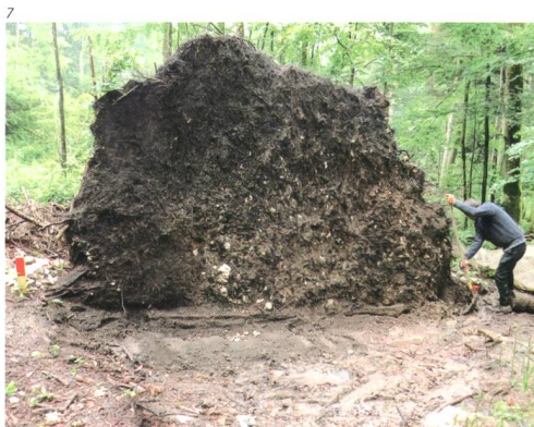
Abb. 6 Dornach / Goben. Beginn der Aushubarbeiten für das neue Trinkwasserreservoir.
