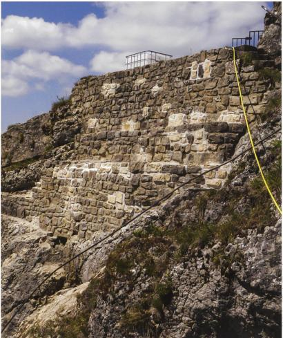
nen liess sich hingegen die Frage, ob der damals verwendete verlängerte Zementmörtel<sup>4</sup> zu hart gewesen sei und dadurch die Schäden verursacht habe. Eine Regel der Baukunst besagt nämlich, dass der Mörtel nie härter als das durch ihn gebundene Steinmaterial sein soll.
