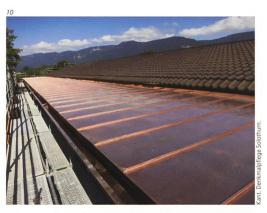
zusätzlich auf die bautechnisch übliche Holzunterkonstruktion montiert. Die Spengler ersetzten ausserdem die kantig geformten Dachrinnen und die Fallrohre. Spezielle Elemente wie beispielsweise die tellerförmigen Wasserfangkästen verwendeten sie wieder (Abb. 9 und 10).
