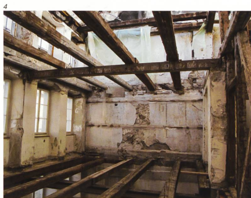
Abb. 4 Hauptgasse 54, Solothurn. Bauuntersuchung nach dem Brand von 2011, Zustand nach den Demontagearbeiten. Gebäudeaufstockungen und Wandmalereien von 1686 konnten dabei nachgewiesen werden. Foto 2011.
