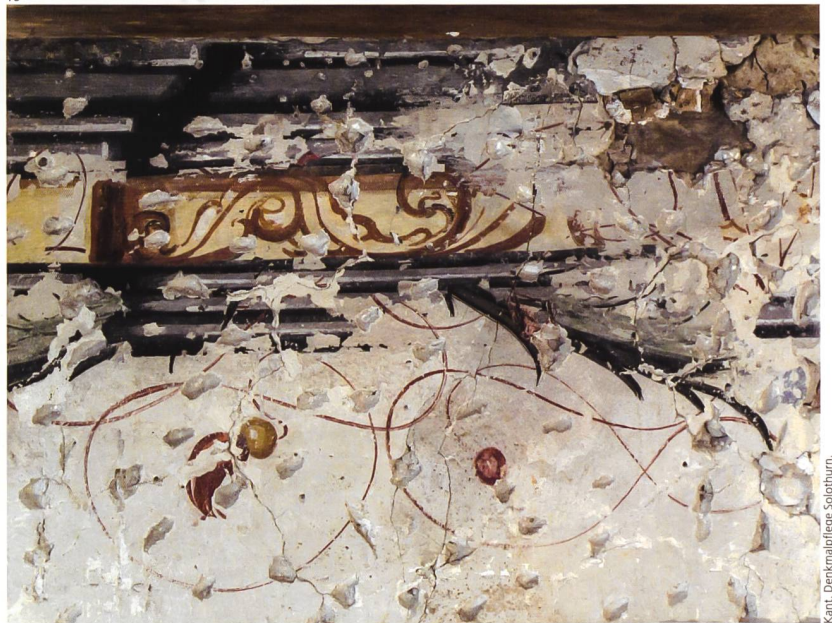
Abb. 9 Klosterplatz 9, Solothurn. Ehemaliges Chorherrenhaus. Beispiel einer bei Sondierungen partiell freigelegten Malerei, um 1680. Verschiedene Mal- schichten liegen übereinander. Foto 2013.
