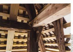
Abb. 8–11 Eckverbindung im Vorzustand mit Betonflick und unsere Reparatur.
