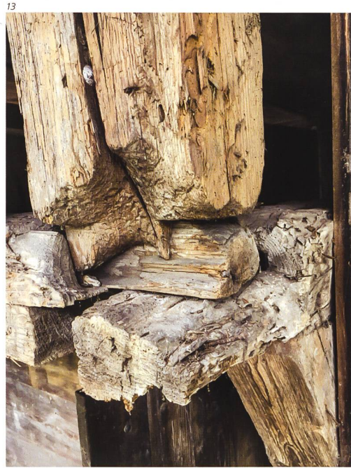
Abb. 13–15 Vorzustand und Reparatur der umlaufenden Lauben- konstruktion.
