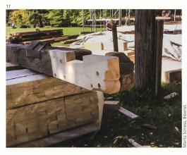
struktionshölzern waren zudem mit Beton ausgefüllt worden. Da Holz und Beton aber unterschiedliche hygroskopische Eigenschaften besitzen und Beton ein Feuchtigkeitsspeicher ist, führten die vermeintlichen Reparaturen zu einer Vergrösserung der Schäden (Abb. 8–11).
