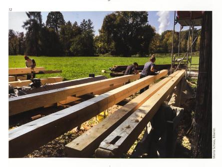
ten Eckverbindungen der Laubenpfetten und an diesen selbst Reparaturen vorzunehmen, mussten wir die Sparren abbauen und neben dem Speicher ablegen. Danach bauten wir die umlaufende Laubenkonstruktion nach sorgfältiger Vermessung und Beschriftung ebenfalls ab, damit wir auf dem Abbundplatz daran arbeiten konnten (Abb. 12).
