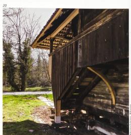
sichtbaren Länge auf, zwei Bohlen (die dicken Bretter der Konstruktion) der Giebelwand waren zerstört. Der Abfluss des Regenwassers war nicht mehr gewährleistet, das Wasser lief in die Zapfenverbindungen und beschädigte das Holz der Auflager. Um diesen Abfluss wieder herzustellen, demontierten wir den Firstpfosten und die Giebelwand und restaurierten sie auf dem Abbundplatz.
