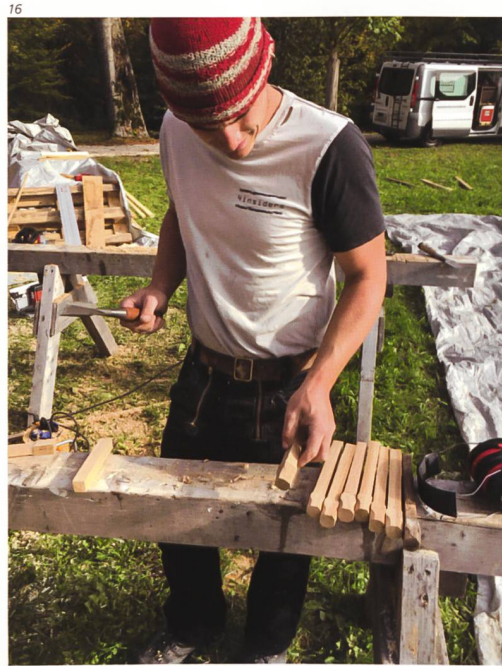
Abb. 16 und 17 Anfertigen von Holznägeln zum Sichern der Verbindungen.
