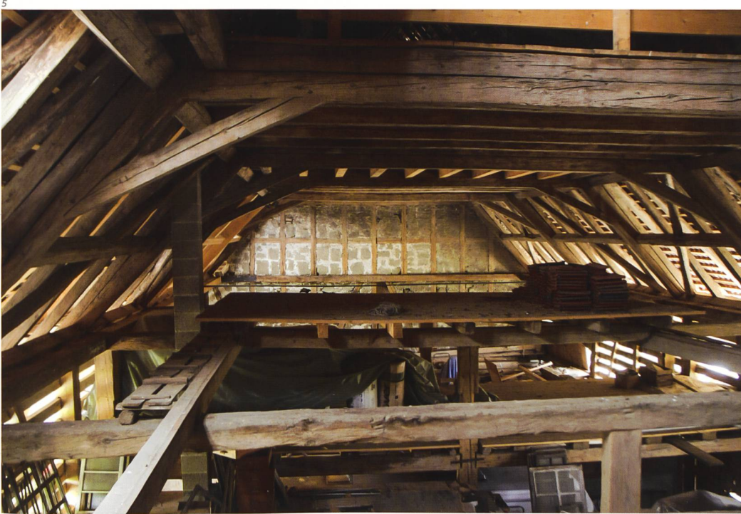
Abb. 5 Blick vom Dachboden des Wohnhauses über den Heustock des Ökonomieteils auf die Rückwand des Gesinde- wohnteils.
