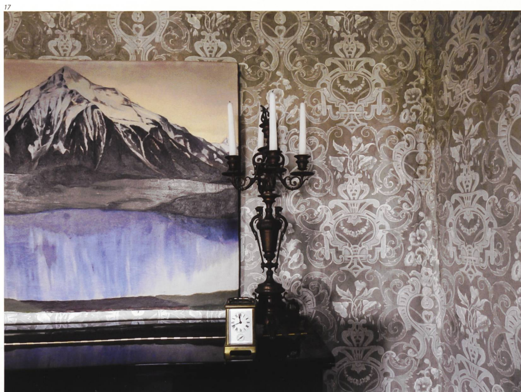
Abb. 17–21 Detailaufnahmen der in situ konservierten Tapeten in Stube und Kinderzimmer des Ober- geschosses.
