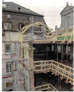
Abb. 42 Blick in das neu aufgerichtete Mansardgeschoss des südlichen Annexbaus.
