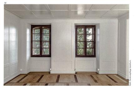
Abb. 18 Stube im Erdgeschoss, Blick gegen Süden mit den restaurierten einfachverglasten Fenstern aus Eiche mit Vorfenstern. Foto 2016.
