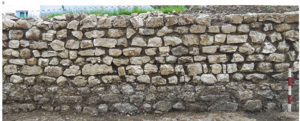
Abb. 7 Umgestürztes Mauerstück M3 mit drei Ziegelausgleichslagen.
