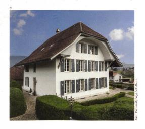
Im Zusammenhang mit einem Wechsel im Pfarramt, der Renovation der Wohnräume und der Aufteilung in zwei Wohnungen wurden 2014 auch die Fassaden restauriert. Dazu gehörten eine Verputzsanierung, die Erneuerung der Fenster, die Restaurierung des Holzwerks und die Malerarbeiten.
