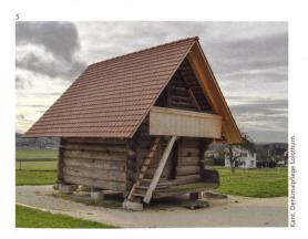
des Holzwerks, im Ersatz morscher Konstruktionshölzer und in der Neubedachung in Einfachdeckung mit neuen Biberschwanzziegeln. Die historisch richtige Neigung und Länge des Dachs wurde anhand von regionalen Vergleichsbeispielen bestimmt. Auf dem neu geschaffenen, von Strauchwerk befreiten Mergelplatz ist der Speicher nun wieder als eigentliches Schmuckstück des Hofs zu erkennen.
