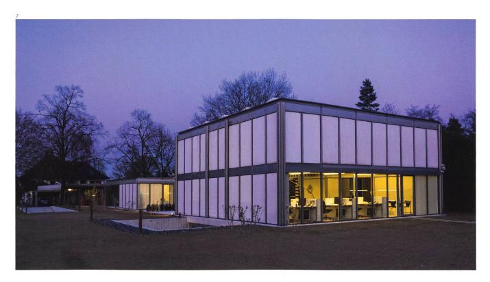
nen Fassadenteile. Die neuen Glasabschlüsse liessen sich unter Verwendung der bauzeitlichen Gummidichtungen in die unverändert feingliedrige Fassadenkonstruktion integrieren.
