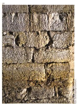
Abb. 19 Detail der Steinbearbeitung am Joch der alten Stadtgrabenbrücke: Die Tuffsteingurte sind gebeilt, die Kalksteinquader gespitzt. Foto 2016.
