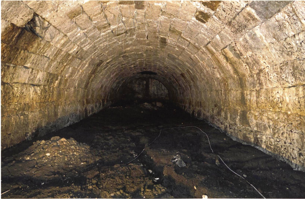
Abb. 15 Barockes Gewölbe, Blick gegen Norden. Der Boden ist mit einer 70–90 Zentimeter dicken Sedimentschicht bedeckt. Gut erkennbar ist der ehemalige maximale Wasserstand während der Nutzung des Gewölbes als Abwasserkaverne. Hinten ist die nachträgliche Zumauerung sichtbar. Foto 2016.
