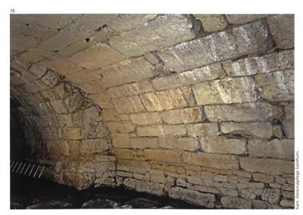
Abb. 17 Nördliche Zumauerung zur Abwasserkaverne. Foto 2016. In der Mitte der gegen oben führende Schacht zur Entlüftung und Einleitung des Oberflächenwassers. Links unten die heute zum Teil eingestürzte Einlassöffnung des Abwasserkanals.
