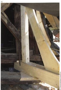
Abb. 14 Schäden an der Holzschwelle des Dachstuhls, entstanden durch eindringendes Wasser. Das Turmdach drohte gegen Westen abzuknicken.
