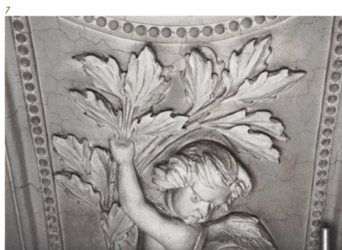
Abb. 8 Detail der Stuckaturen während der Restaurierung. Die Sanierung von Hohlstellen erfolgte mittels konisch geöffneter Bohrlöcher, in die Mörtelpfropfen als Verankerungen eingesetzt wurden.
