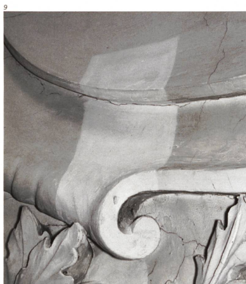
Abb. 10 Die Sanierung von statischen Rissen im Gewölbebereich erfolgte durch das Verfüllen mit feinem Grundputz, der nach kurzem Antrocknen abgeglättet wurde.
