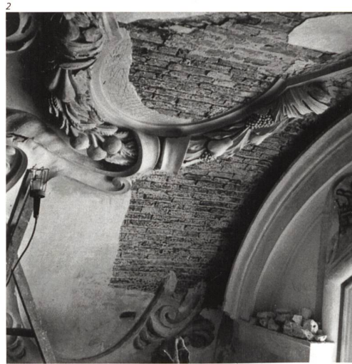
Abb. 2 Detail des Gewölbebereichs während der Restaurierung 1952/53. Teilweise mussten grössere Partien neu verputzt und stuckiert werden. Gut sichtbar ist auch das Backsteingewölbe als Träger der Stuckaturen.
