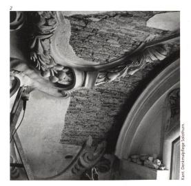
Abb. 2 Detail des Gewölbebereichs während der Restaurierung 1952/53. Teilweise mussten grössere Partien neu verputzt und stuckiert werden. Gut sichtbar ist auch das Backsteingewölbe als Träger der Stuckaturen.
