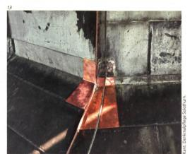
lung mit schwarzem Decklack neu gestrichen. Und schliesslich erwies sich auch die Verankerung des Kreuzes in der Laterne als mangelhaft, sodass eine zusätzliche Befestigung mittels einer neu konstruierten und versteckt montierten Metallmanschette notwendig wurde.
