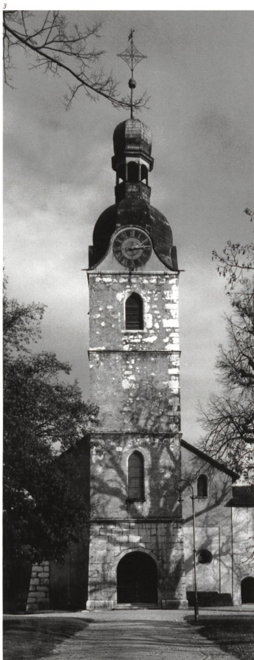
Abb. 3 Der Kirchturm im Zustand vor der Restaurierung 1958. Der Verputz ist stark reduziert, sodass das Bruchsteinmauerwerk deutlich zum Vorschein kommt.
