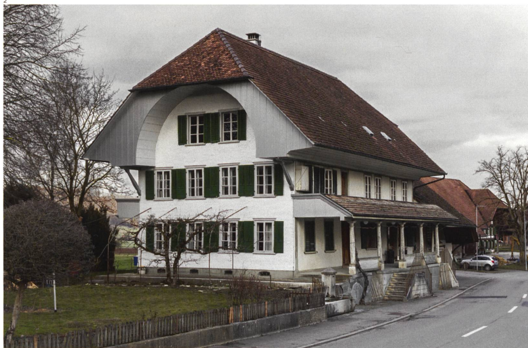
Abb. 2 Ansicht von Südwesten, nach der Restaurierung 2013–2015.
