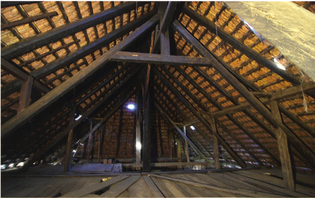
Abb. 6 Blick in den Dachboden mit Hochstudkonstruktion, Aufnahme 2013, vor der Restaurierung.
