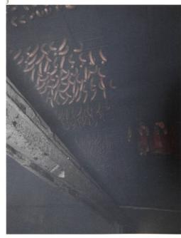
Abb. 2 Die verrusste Holzkonstruktion im Obergeschoss, Foto 2013.
