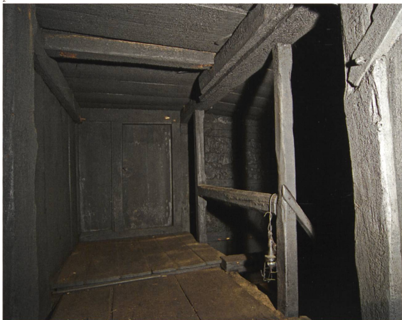
Abb. 2 Die verusste Holzkonstruktion im Obergeschoss, Foto 2013.
